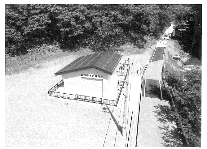
写真-7 笹川小水力発電所の外観
