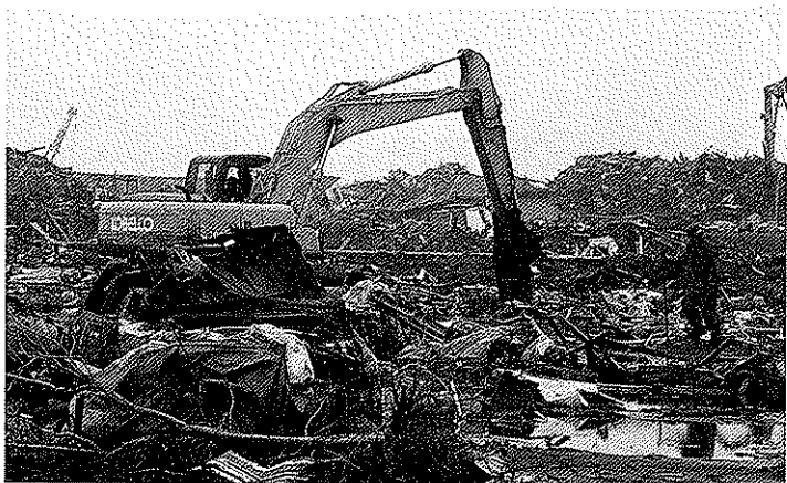
行方不明者の捜索を行いながらのがれき撤去作業
