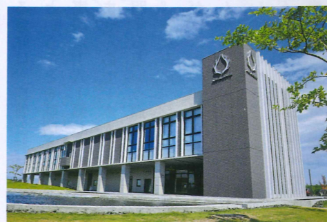
地域に人を呼び込む施設の核にしたのは、地下1000mから湧く天然温泉
