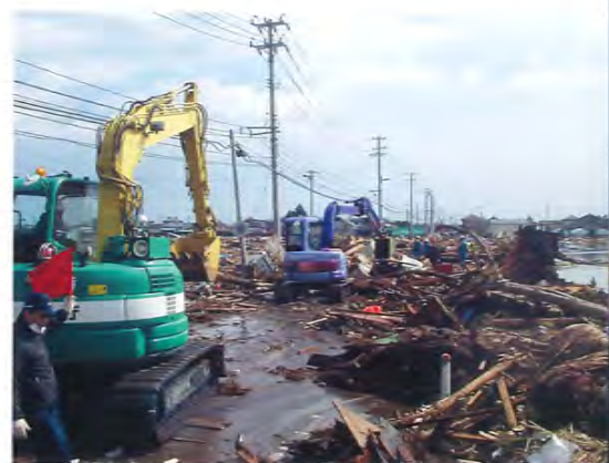
① 道路啓開作業
