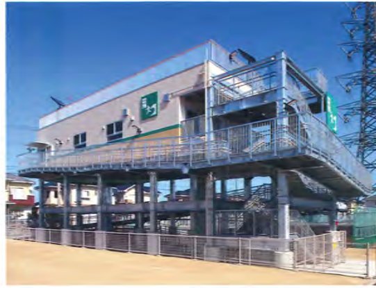
6 津波避難施設
