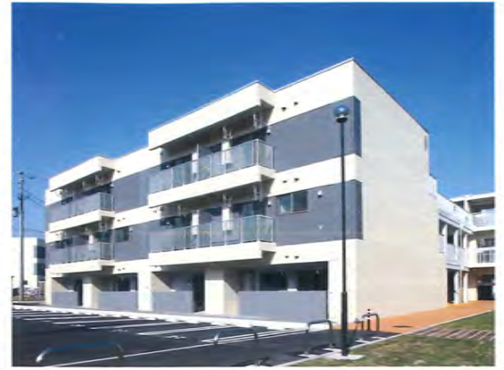
5 災害公営住宅
