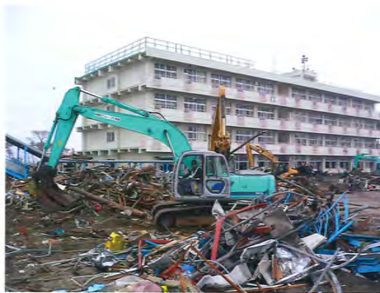
② 瓦礫の撤去作業
