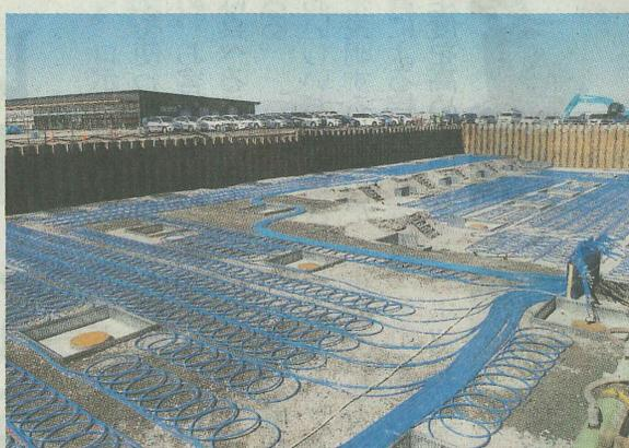
温泉棟地下に敷設した樹脂製のスリンキー式コイル
