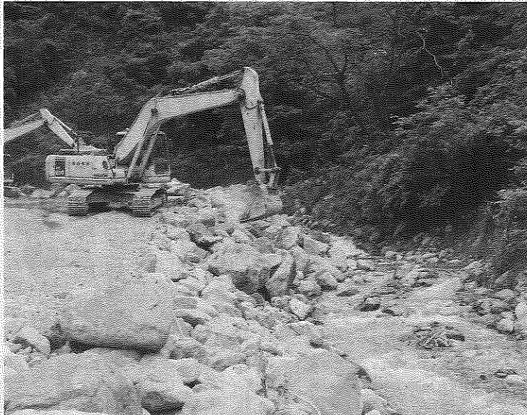
朝日町の笹川では小水力発電所の建設工事が進む(6月)
