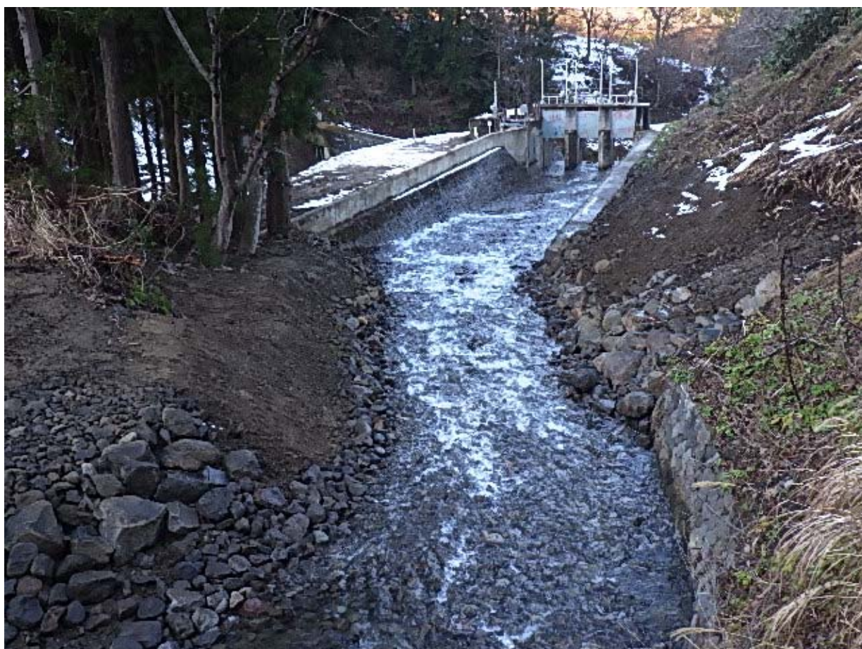
・土路川完了(上流より)
