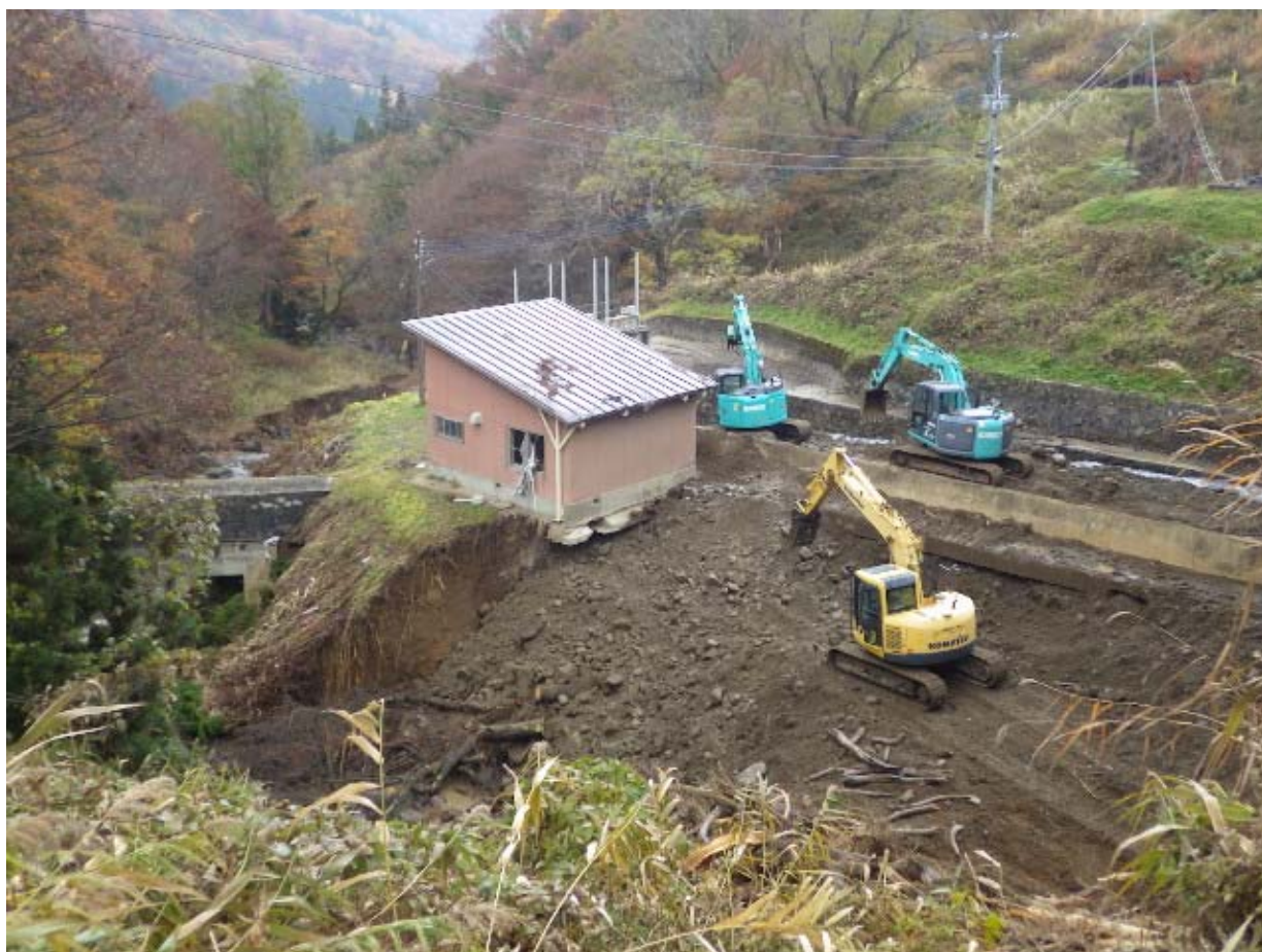
・土路川堰堤土砂排除 2
