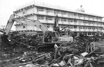
●初期期でのがれき撤去作業。建設業者、解体業者、産業廃棄物処理業者が団結して処理した。
