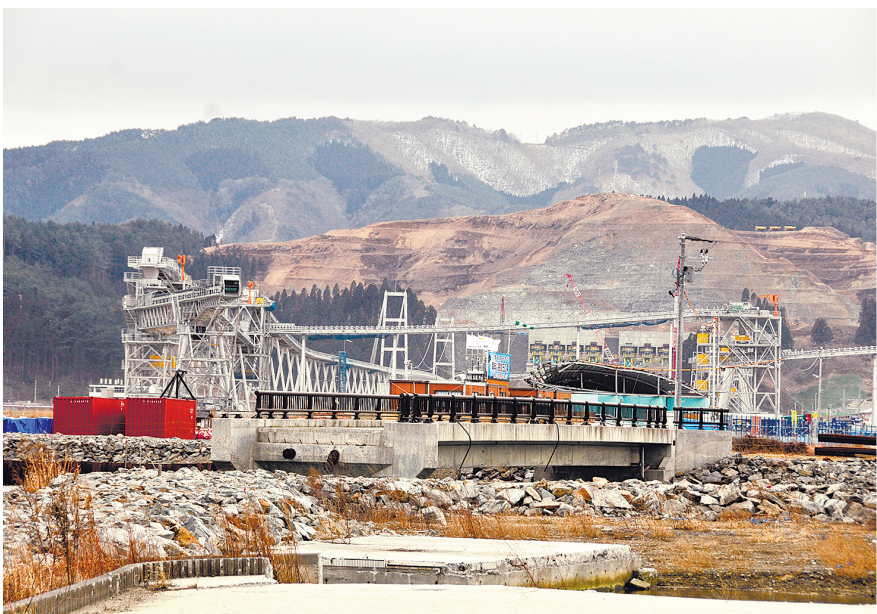
復興CM方式により壊滅的な被害を受けた市街地の再生に取り組む岩手県遠前高田市。住宅地の高台移転で生じる大量の土砂を旧市街地のかさ上げに活用するため、気仙川を隔てて切り出した土壌を輸送する大型ベルトコンベヤーが整備されている
