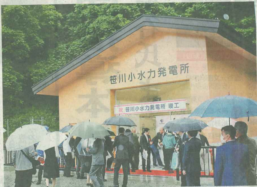
笹川の水を利用して発電する笹川小水力発電所 ＝6月30日、朝日町笹川地区
